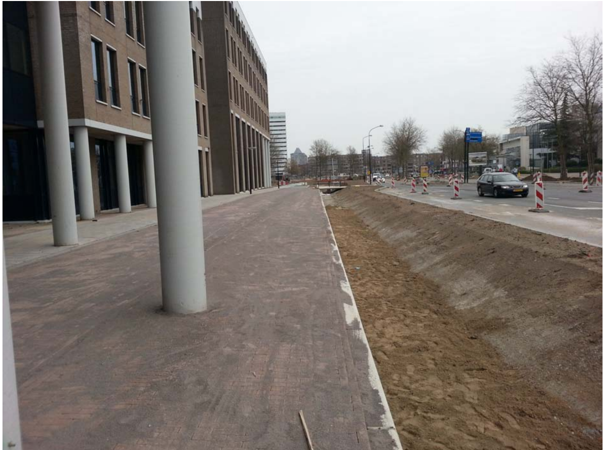
Aanleg Grift Prins Willem Alexanderlaan april 2013
