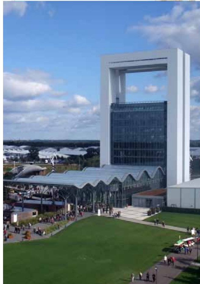
De innovatortoren op het Floriade terrein is enorm duurzaam met diverse zichtbare technieken
